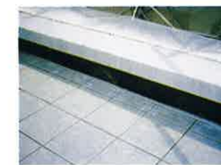
立上がり施工
