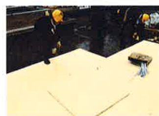
高性能発泡ポリスチレン断熱材の敷込み
