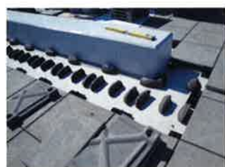
DVブロックの据付け(端部納まり例)
