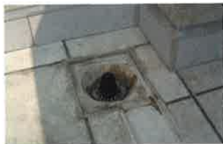
▲縦引きドレーン部分 (片側の開口部分は左官モルタル仕上げ)
