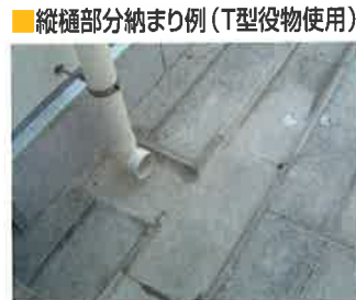
▲縦引きドレーン部分 (片側の開口部分は左官モルタル仕上げ)
