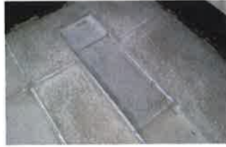
▲伸縮目地との取り合い部分
